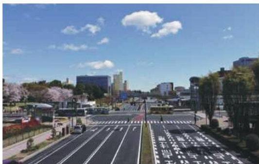
電線類が地中化されたTXつくば駅前
