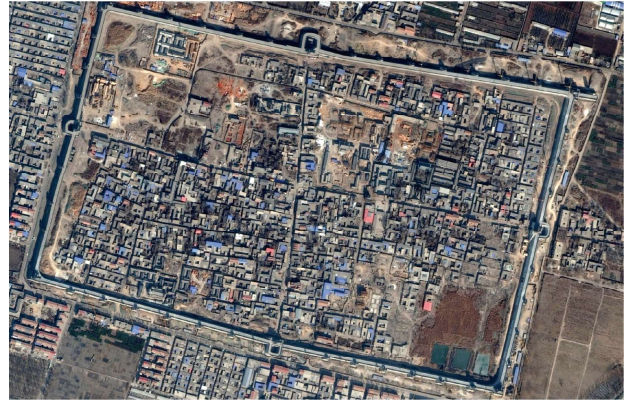
取り壊された城壁の再建と復元的都市再開発 2017年8月調査
